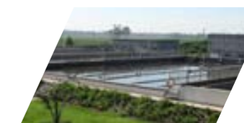
城镇污水提升
