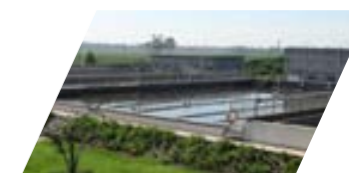
城镇污水提升
